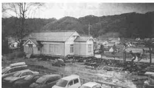
総合学科棟建設のための記念館の移転工事
