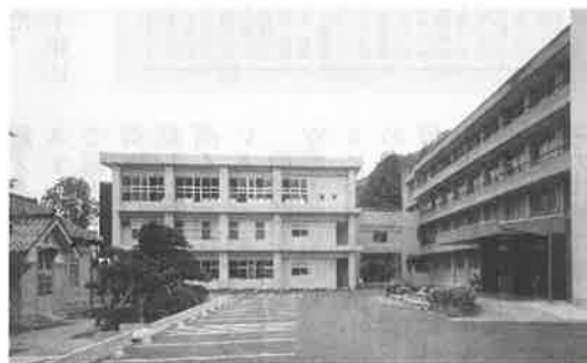
新しくなった玄関前付近
